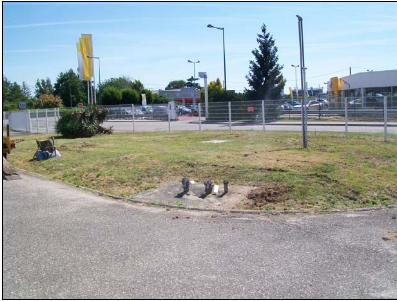
Figure 14 : Aperçu de la station-service (juin 2012).
